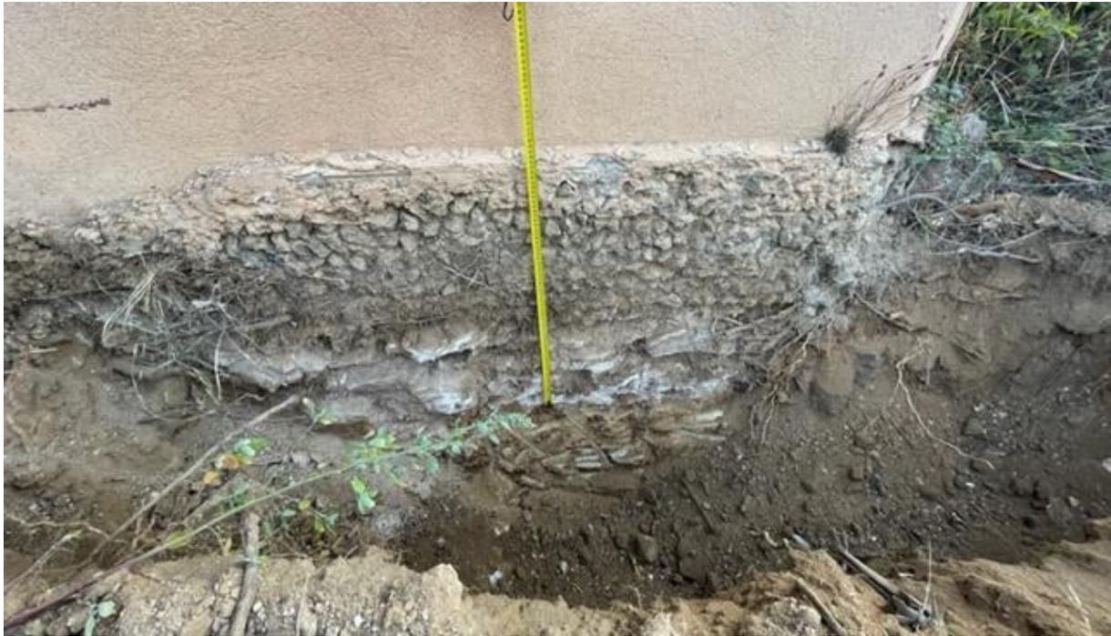
Les fouilles de reconnaissance ont montré une **absence de débord** et un encastrement de l'ordre de 50.00cm côté Ouest et supérieur à 2.00m côté Est (partie avec cave). Les sondages ont confirmé que ces **moellons reposaient sur le substratum Gneissique**.
